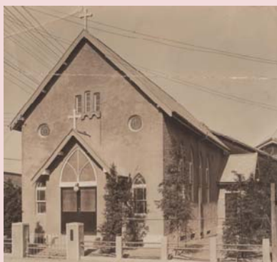
昭和9年に建てられたかつての教会
